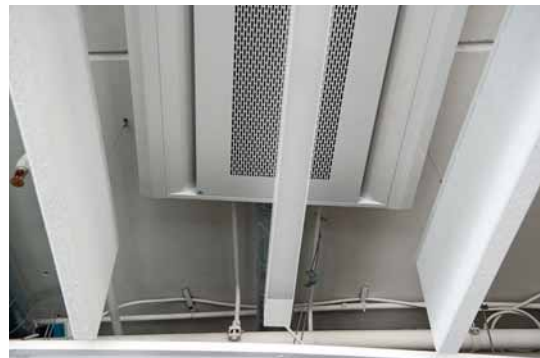
Undertak saknas, medan taket är försett med ljudabsorbenter.
